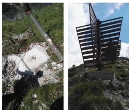
Figura 11 – V. Ruine: rifacimento del plinto di fondazione del puntone tubolare delle reti da neve (sx) e potenziamento del plinto di fondazione della struttura frangivento (dx)
