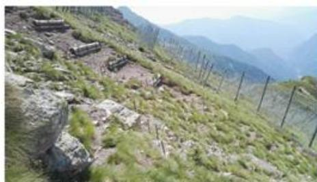
Figura 12 – V. Ruine: Fase di realizzazione delle palificate in legno finalizzate alla mitigazione dei fenomeni
