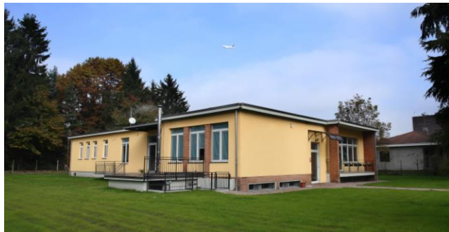
Edificio scolastico pre-esistente (ex scuola elementare)
